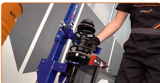
**32** Installieren Sie das Federbein am Radlauf.
