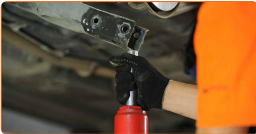
**20** Bringen Sie die Befestigungsschraube an. Verwenden Sie einen Splintentreiber. Benutzen Sie ein Brecheisen. Verwenden Sie Stecknuss Nr. 21. Verwenden Sie einen Ratschenschlüssel.
