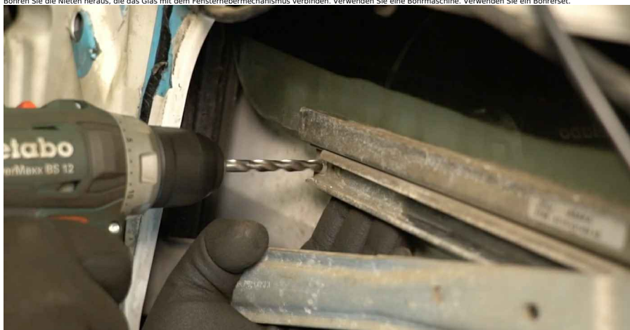
14 Bohren Sie die Nieten heraus, die den Fensterhebermechanismus mit der Tür verbinden. Verwenden Sie eine Bohrmaschine. Verwenden Sie ein Bohrer-set.
