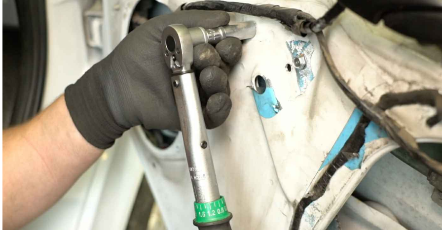
23 Schließen Sie den Stecker an den Fensterhebermotor an.
