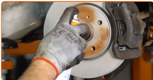
**30** Die Bremsscheibenoberfläche reinigen. Benutzen Sie einen Bremsenreiniger.
